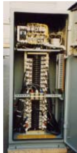
그림 6 CAM CONTACTOR 방식 기동저항기 Fig. 6 CAM type starter
